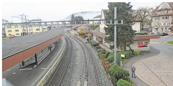
Der Mittelperron des Bahnhofs wird aufgehoben, der Güterschuppen abgebrochen.
